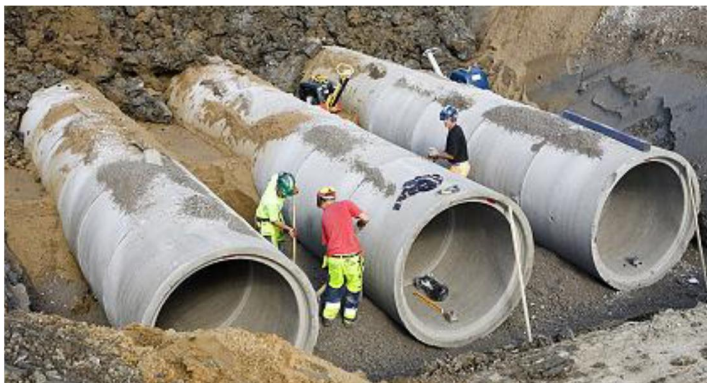
Bild 7. Dagvattenmagasin av betongrör Källa: www.steriks.se .
