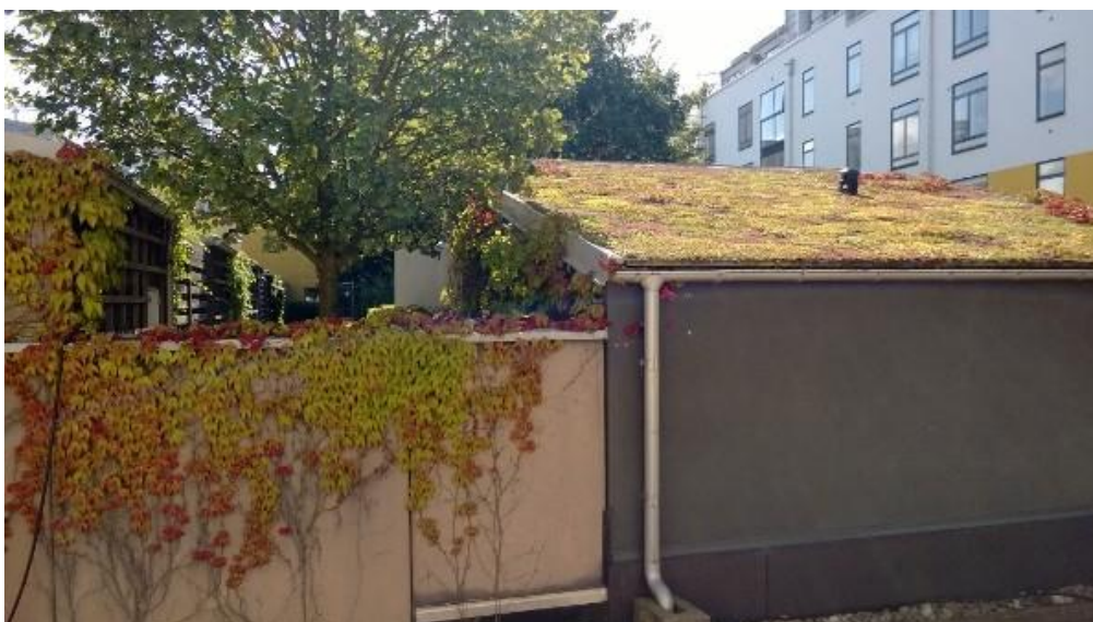
Bild 8. Grönt tak och vägg på förrådsbyggnad, Bo01 i Malmö. Foto taget
