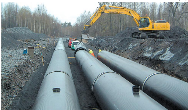
Bild 6. Dagvattenmagasin av Weholite dubbelväggiga lättviktsrör, polyeten. Källa: www.kwhpipe.se
